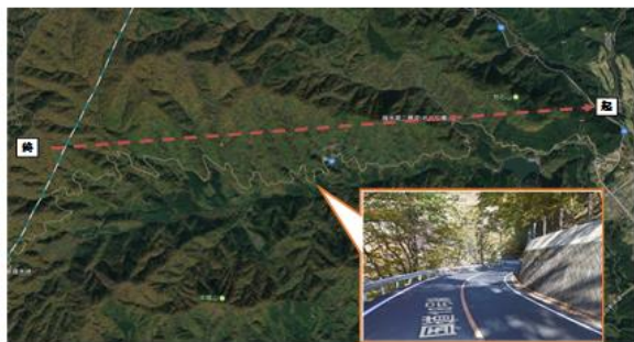
図 13 50km/h 未達成区間の道路状況(区間⑧)
